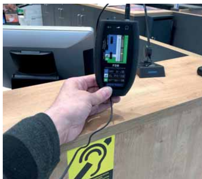
Instalace a měření funkčnosti indukční smyčky pro uživatele sluchadel na informační přepážce obchodu Kaufland v Ostrově nad Ohří
